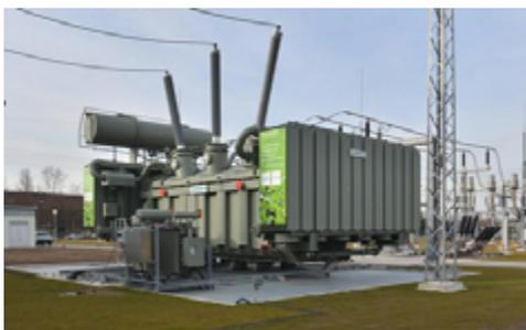
**Bild 8:** 380kV Transformator im Umspannwerk Bruchsal-Kandelweg der TransnetBW
