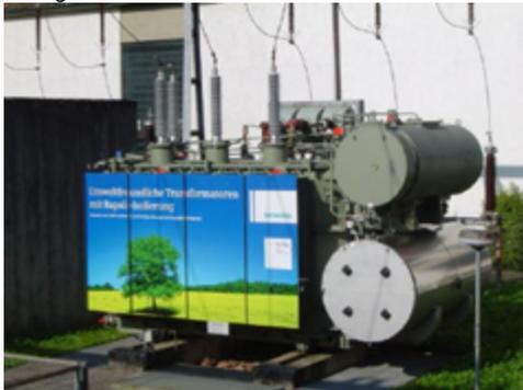
**Bild 5:** 110kV Transformator im Umspannwerk Teinach der Netze-BW
