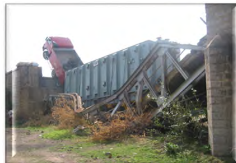
Bild 3: Beispiel für Transportschaden
