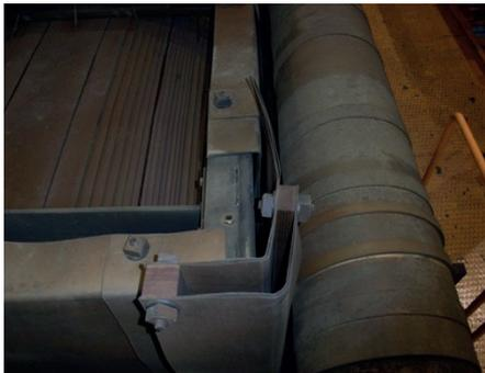
Abbildung 4: Alte Isolation der Jocheisenkante
