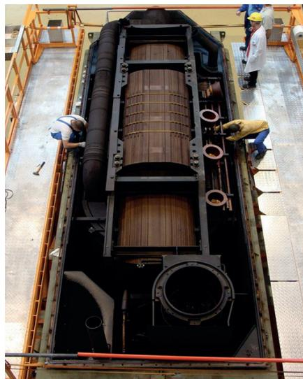
Abbildung 2: 266MVA-Trafo nach Öffnung
