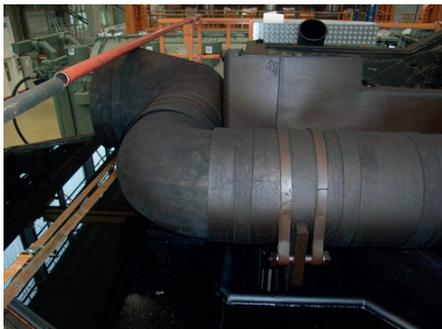
Abbildung 3: Alte HV-Ausleitung, 266MVA-Trafo
