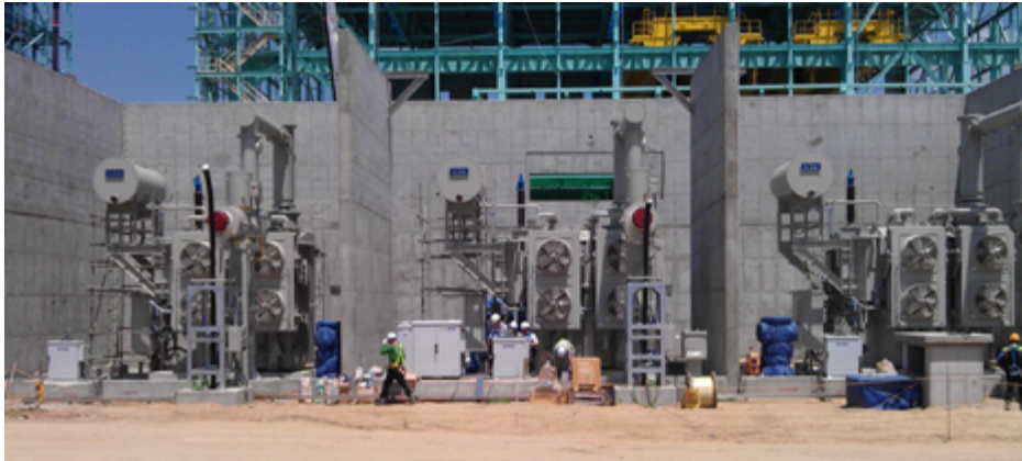
Online DGA zur Überwachung von 1, 2 oder 3 Öltransformatoren
